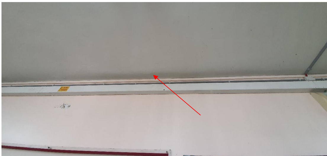
סדק בקצה התקרה מקורוזיה בברזלי הזיון
